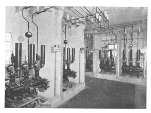
Fig. 43. Modernisierung einer Schaltanlage mit 24-kV-Druckluftschnellschaltern.
