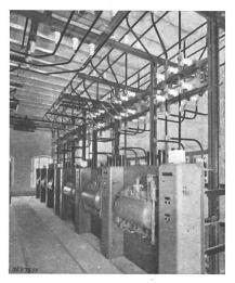
Fig. 44. 24-kV-Schaltanlage in Hallenbauweise mit Druckluftschnellschaltern.
