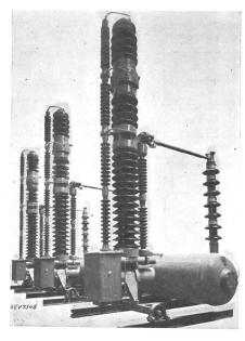
Fig. 39. 150-kV-Druckluftschnellschaltergruppe für Freiluft mit Einrichtung für rasches Wiedereinschalten.
