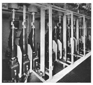
Fig. 2. Schaltanlage mit 11-kV-Wasserschaltern.
