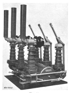
Fig. 16. 64-kV-Druckluftschnellschalter für Innenraum in Offenstellung. Abschaltleistung 800 MVA.
