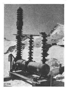
Fig. 29. 150-kV-Druckluftschnellschalter auf dem Jungfraujoch.
