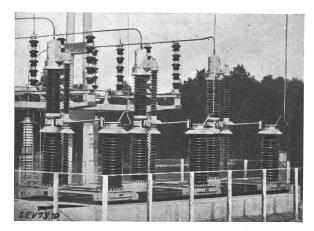
Fig. 3. 220-kV-Konvektorschalter.
