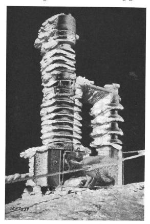
Fig. 32. 87-kV-Schalter mit Rauhreif auf dem Säntisgipfel.
