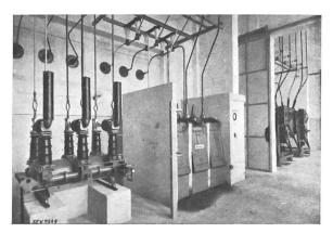
Fig. 42. Ersatz von 50-kV-Oelschaltern durch Druckluftschnellschalter.
