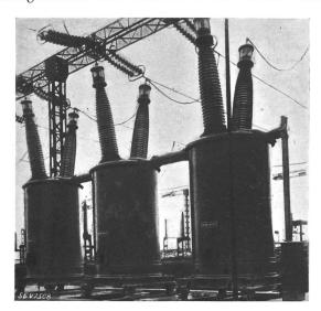
Fig. 1. 220-kV-Kesselölschalter.
