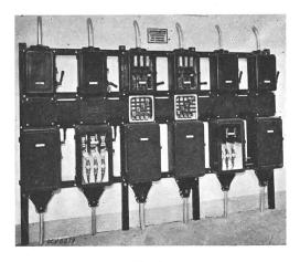
Fig. 1. Gekapselte Niederspannungsverteilung von C. Maier & Co., Schaffhausen.
