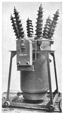
Fig. 5. Einkessel-Freiluft-Oelschalter, 64 kV, 600 MVA.
