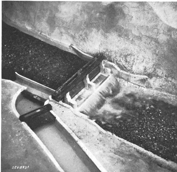
Fig. 5. Wasserfassung zum Mitteldruckwerk.
