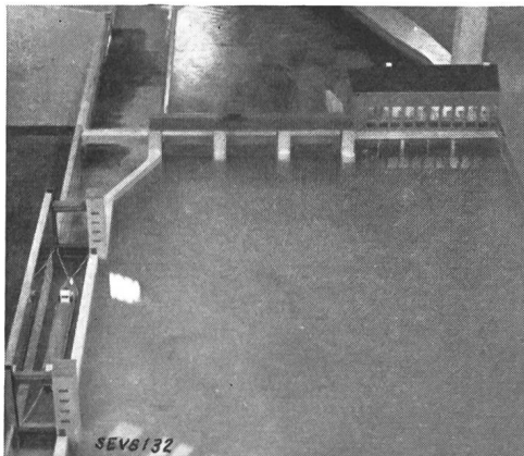
Fig. 6. Niederdruckwerk; links Schiffschleuse.
