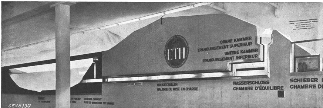
Fig. 4. Hochdruckanlage im Schnitt gesehen.
