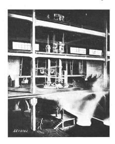
fehlen, sondern weil die vorhandenen verhältnismässig arm und unrein und deshalb bis heute einer technisch-wirtschaftlichen Aufbereitung für die Schmelz-Elektrolyse verschlossen geblieben sind. Bei der Schmelz-Elektrolyse bewirkt die elektrische Energie als Wärmespender und Reduktionsmittel den Schmelzfluss und die Dissoziation des Aluminiumoxyds in metallisches Aluminium und Sauerstoff. Sauerstoff hat den Abbrand der Kohlenelek-
