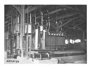
Fig. 8. Filterpresse-Elektrolyseur.
