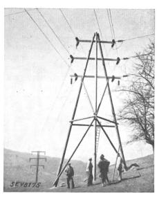
Fig. 1. Holz im Leitungsbau. 80 kV-Doppelleitung.
