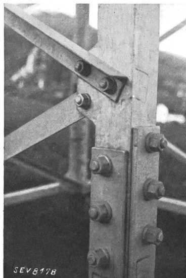
Fig. 4. Mastpfosten mit angeschweisstem Knotenblech.
