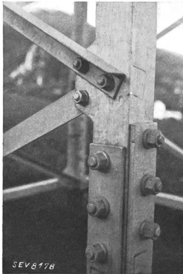
Fig. 4. Mastpfosten mit angeschweisstem Knotenblech.
