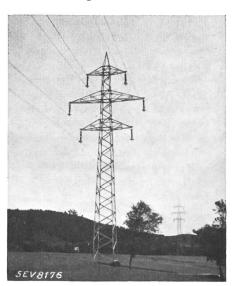
Fig. 2. 150 kV-Doppelleitung.
