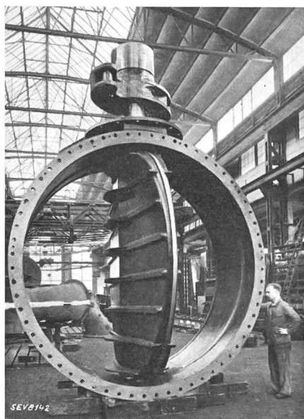
Fig. 1. Drosselklappe. (Escher-Wyss.)
