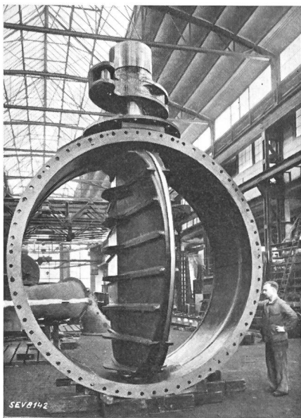
Fig. 1. Drosselklappe. (Escher-Wyss.)
