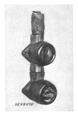
ihrer ganzen Länge noch besonders geschützt waren. Die Kabelenden waren gegen das Eindringen von Feuchtigkeit dicht abgeschlossen und die Kupferrohre durch angelötete eiserne Gewindemuffen mit den Drehschaltern aus Isolierpreßstoff (Ausführung für nasse Wände) verschraubt.
