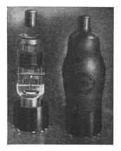
Fig. 6. Die neue Regelröhre EF 9.
