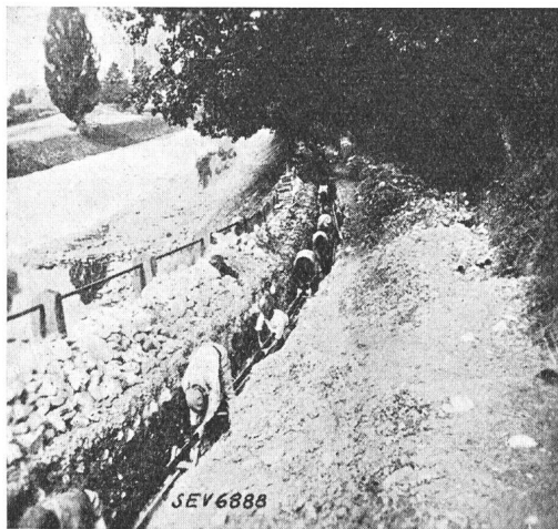
Fig. 30. Kabeltransport auf Rollen im Kabelgraben.
