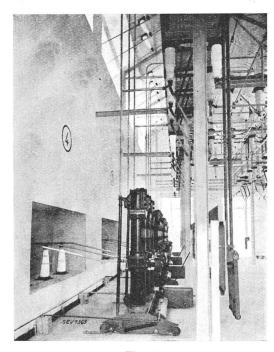
Fig. 5. Oelstrahlschalter für Innenraum 60 kV, in der Schaltanlage Bramois der Aluminium-Industrie A.-G., Neuhausen.
