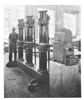
Fig. 3. Oelstrahlschalter für Innenraum 60 kV, 750 MVA, mit Motorantrieb.
