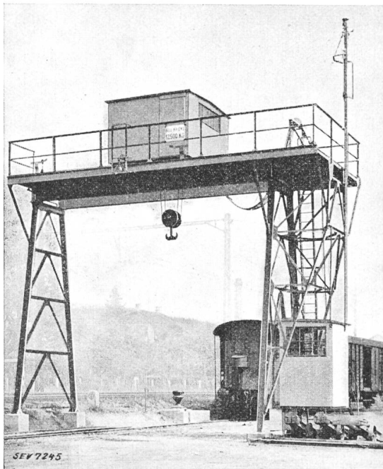
Fig. 5. Feststehender Bockkran mit Rangierspill.
