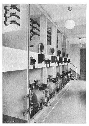
Fig. 5. Zellenreihe mit MFO-Schaltern.
