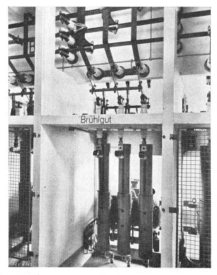
Fig. 6. Schalterzelle mit MFO-Schalter.
