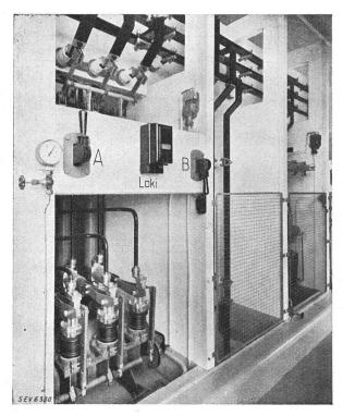
Fig. 3. Zellenreihe mit eingebauten Brown-Boveri-Schaltern.
