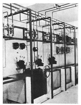
Fig. 14. Schaltstation Rieter. Zellenreihe während der Montage.
