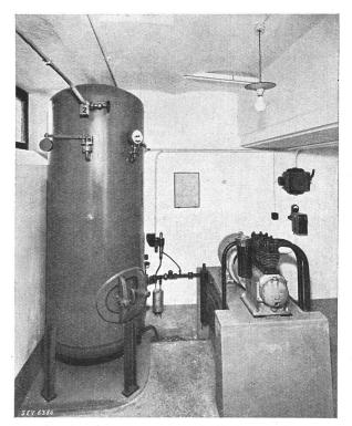
Fig. 9. Kompressor-Anlage.
