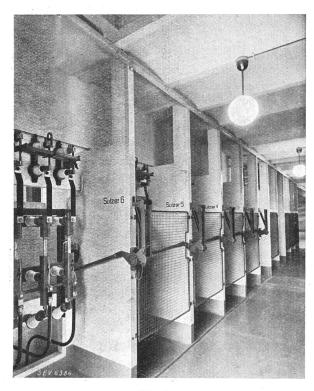
Fig. 7. Zellenreihe mit Sprecher & Schuh-Lasttrennern.
