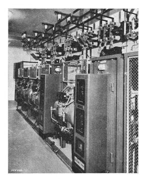
Fig. 9. Einbau der Brown-Boveri-Distanzrelais.
