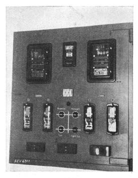
Fig. 10. Einbau der Energierichtungsrelais.
