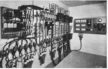
Fig. 6. Sekundäranlage mit Maschennetzschalter und Steckautomaten.
