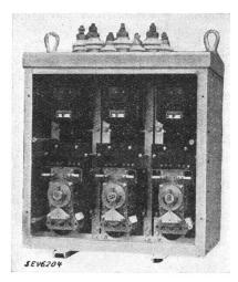
Fig. 2. Nivo-Regler für 50 kVA Durchgangsleistung, geöffnet.
