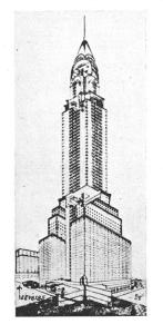
Fig. 4. Das Chrysler-Gebäude mit ber 6000 kW totalem Ar schlusswert. Installierte Transformatorenleistung 3600 kVA. Gemessene Spitzenleistung 2500 kW.
