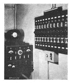
Fig. 4. Oscillographe avec accessoires et tableau des lignes.
