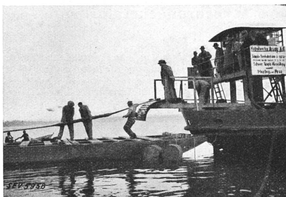
Fig. 9. Descente du manchon.
