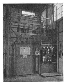
Fig. 4. Transformatorenstation 8000/600 V.
