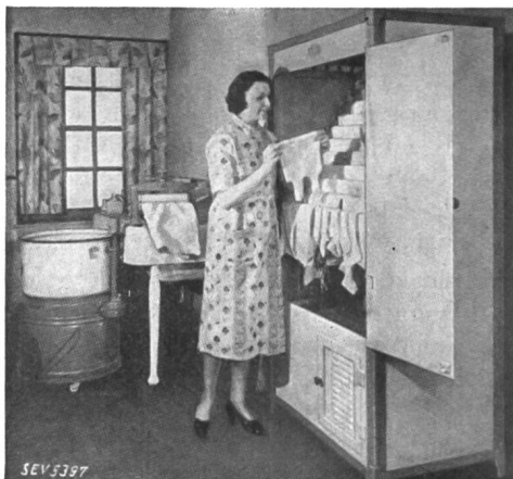
Fig. 52. Wärmeschrank zum Trocknen von Wäsche.
