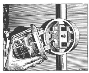
Fig. 33. Steckkontakt-Sockel von Westinghouse-Zählern.
