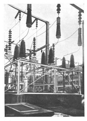
Fig. 16. Câble d'essai 150 kV. Sous-station de Bottmingen.
