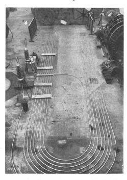
Fig. 11. Câble d'essai sur la plateforme du laboratoire.
