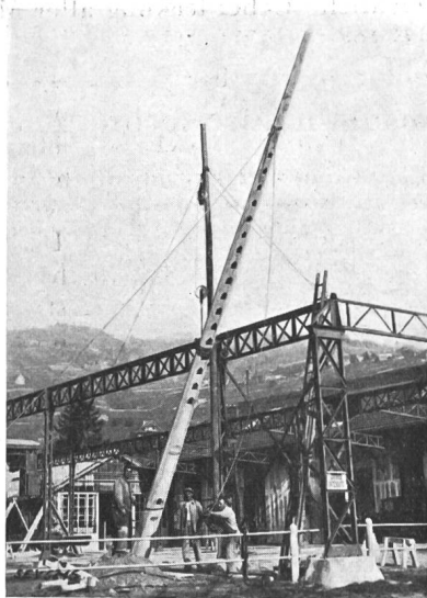
Fig. 3. Aufstellen des Mastes.
