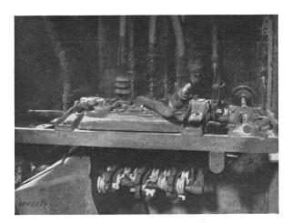
Fig. 3. Reste des Oelschalters in der Zelle.
