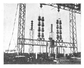
${\rm Fig.~5.} \\ {\rm Couplage~bifilaire~sur~une~ligne~de~150~kV.}$
