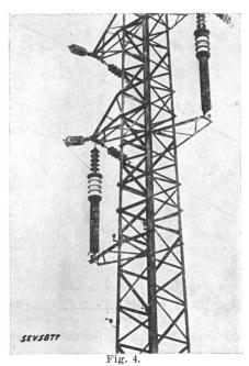
Couplage bifilaire sur une ligne de 60 kV.
