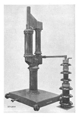
Fig. 43. Oelarmer Schalter Oerlikon für 50 kV, 600 A. (Versuchsausführung für Innenraumaufstellung.)
