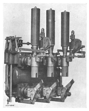
${\rm Fig.~18.} \\ {\rm Brown\text{-}Boveri\text{-}Druckluftschnellschalter~f\"{u}r~6~kV,~400~A.}$
