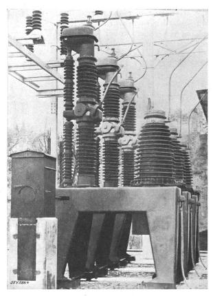
Fig. 39. Oelarmer Schalter Sprecher & Schuh für 150 kV Nennspannung.
