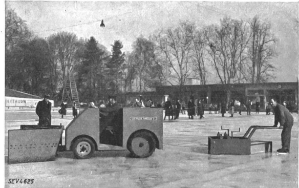
Fig. 3. Eistraktor der Kunsteisbahn Basel mit Schneeräumer und Eishobel.
