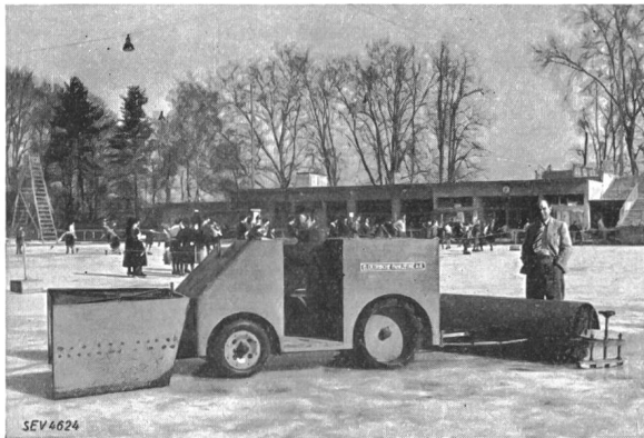
Fig. 2. Eistraktor der Kunsteisbahn Basel mit Schneeräumer und Kehrwalze.
