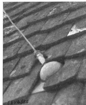
Fig. 3. Dachankereinbindung auf Ziegeldach.
