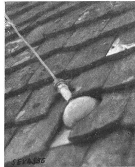
Fig. 3. Dachankereinbindung auf Ziegeldach.
