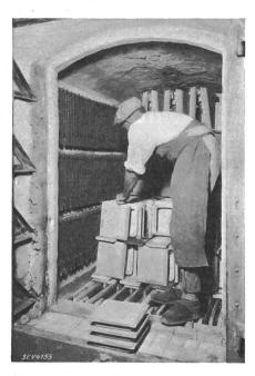
Fig. 8. Chromnickel-Muffelofen zum Brennen von Keramik, 80 kW.
