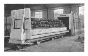
Fig. 11. Glühofen für Eisenknüppel, 350 kW.
