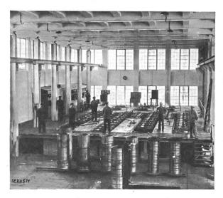
Fig. 1. Blankglühofenanlage, System Brown Boveri-Grünewald bei Sandvikens Jernverks A/B Sandviken (Schweden).
