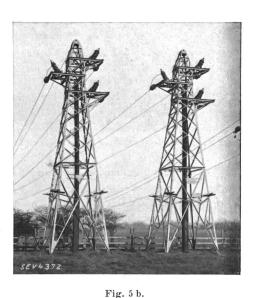
33 kV «Grid»-Sekundärleitungen. Kabel-Endmasten. (Photo CEB.)
