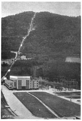
Fig. 9. Maschinenhaus Chandoline mit Druckleitung.
