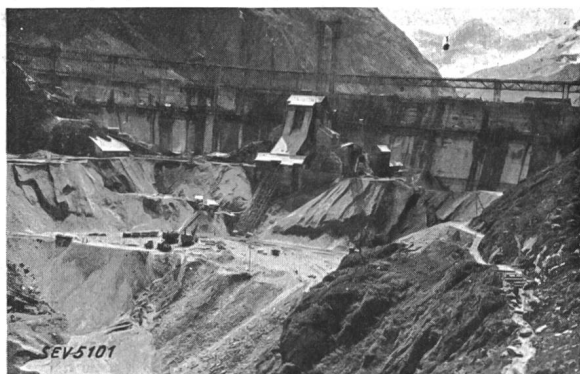
Fig. 12. (Phot. Briffod) Staumauer, Luftseite, mit Betonaufbereitungsanlagen.
