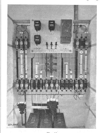
Fig. 13. Schalt- und Verteilanlage für die öffentliche Beleuchtung in der Transf.-Station «Industrie».
