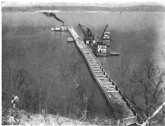
Fig. 3. Baubeginn am Joe Wheeler-Damm. Der Tennessee ist hier über 1800 m breit. Auf dem gegenüberliegenden Flussufer erkennt man die Schiffahrtsschleusen im Bau. Stand der Arbeiten am 11. Dezember 1933.
