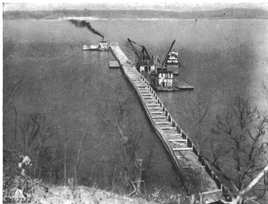
Fig. 3. Baubeginn am Joe Wheeler-Damm. Der Tennessee ist hier über 1800 m breit. Auf dem gegenüberliegenden Flussufer erkennt man die Schifffahrtsschleusen im Bau. Stand der Arbeiten am 11. Dezember 1933.
