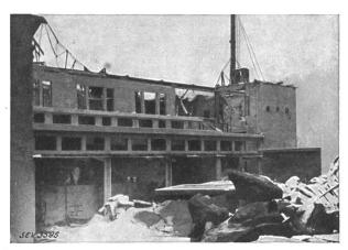
Fig. 5. 1) Rückansicht des Maschinenhauses; im Vordergrund die Bruchstelle.
