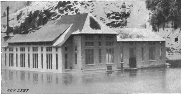
Fig. 4. 1) Vorderansicht des Maschinenhauses nach der Katastrophe. Das Dach links ist völlig eingedrückt.
