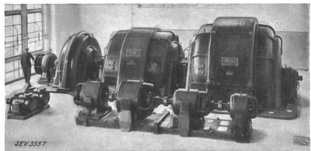
Fig. 24. Frequenzumformer Mühleberg.
