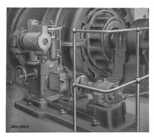
Fig. 7. Regulieraggregat für die Bürstenverstellung.
