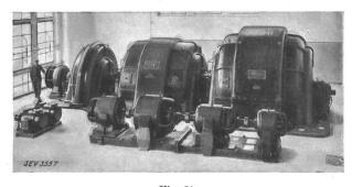
Fig. 24. Frequenzumformer Mühleberg.
