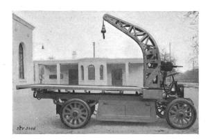
Fig. 2. Lastwagen mit Kranaufbau. Nutzlast 5 t, Kran 2 t.
