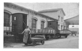
Fig. 6. Elektrokarren beim Ziehen von Eisenbahnwagen.
