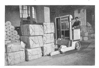
Fig. 15. Elektrostapler beim Abladen von Papierballen.
