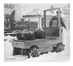
Fig. 5. Stapelkarren im Schnee, 2 t. Hubhöhe 2,5 m.
