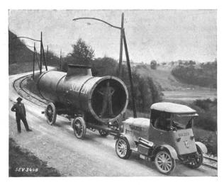
Fig. 3. Akkumulatortraktor. Zugkraft 10 t.
