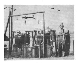
Fig. 2. Ansicht des Kabel-Stossgenerators.
