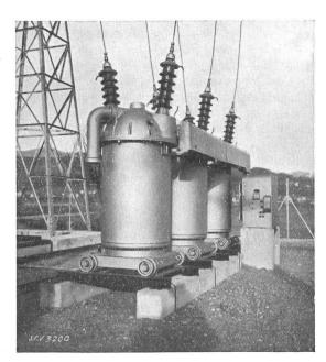
Fig. 8. 50 kV-Oelschaltergruppe.
