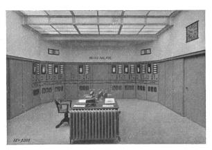
Fig. 11. Schaltstand. Gesamtansicht der Schalttafeln für die 150kV-Anlage.
