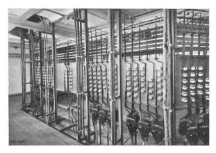
Fig. 14. Kabelverteilanlage für den 150 kV-Teil. Teilansicht (Rückseite).
