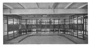
Fig. 13. Kabelverteilanlage für den 150 kV-Teil. Gesamtansicht (Bedienungsseite).
