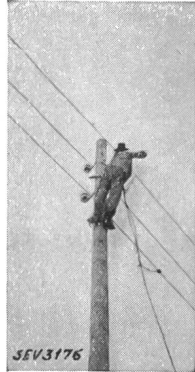
Fig. 9. Kurzschliessen und Erden einer 45-kV-Leitung mit der Wurf-Kurzschlussvorrichtung. Der Monteur ist zum Werfen des Seiles bereit. Fig. 10. Der Monteur schwingt das Seil. Fig. 11. Der Monteur hat das Seil geworfen. Es hat sich um die Leitungsdrähte geschlungen.
