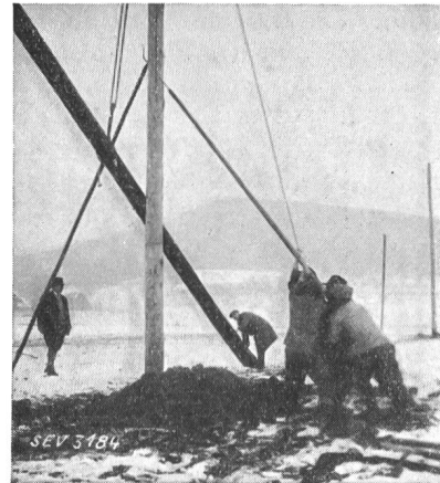
Fig. 19. Ersetzen einer faulen Leitungsstange mit Flaschenzug.
