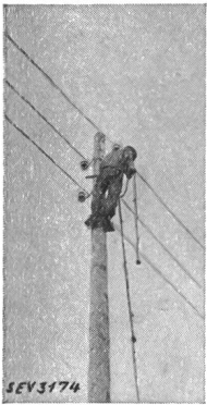
Fig. 9. Kurzschliessen und Erden einer 45-kV-Leitung mit der Wurf-Kurzschlussvorrichtung. Der Monteur ist zum Werfen des Seiles bereit. Fig. 10. Der Monteur schwingt das Seil. Fig. 11. Der Monteur hat das Seil geworfen. Es hat sich um die Leitungsdrähte geschlungen.
