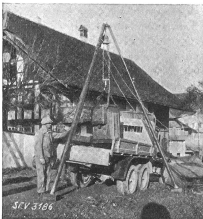
Fig. 21. Abladen eines Transformators vom Lastwagen mit Hilfe des Dreibeines aus Stahlrohren.
