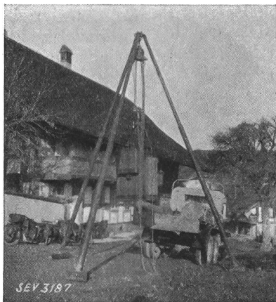
Fig. 21. Abladen eines Transformators vom Lastwagen mit Hilfe des Dreibeines aus Stahlrohren.
