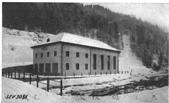
Fig. 1. Maschinenhaus des Kraftwerkes Isles.
