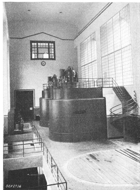
Fig. 13. Maschinensaal. Die zwei aufgestellten Drehstrom- generatoren vom Montageplatz aus gesehen.
