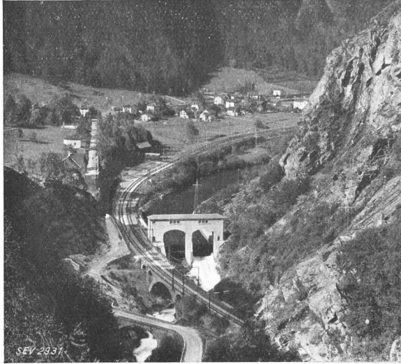
Fig. 3. Wasserfassung bei Rodi. Stauwehr, Ansicht talaufwärts.
