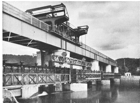
Fig. 6. Oberwasserseitige Ansicht des Stauwehrs mit Notverschlüssen und Notverschlusskran.
