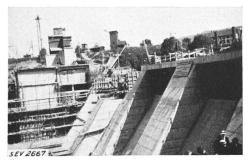
Fig. 3. Kraftwerk Wettingen: Stauwehr, links Maschinenhaus.
