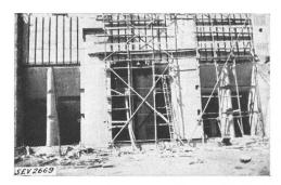
Fig. 5. Kraftwerk Wettingen: Turbineneinläufe.
