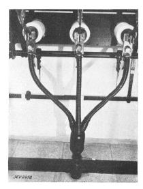
Fig. 6. Hochspannungs-Wickelendverschluss.
