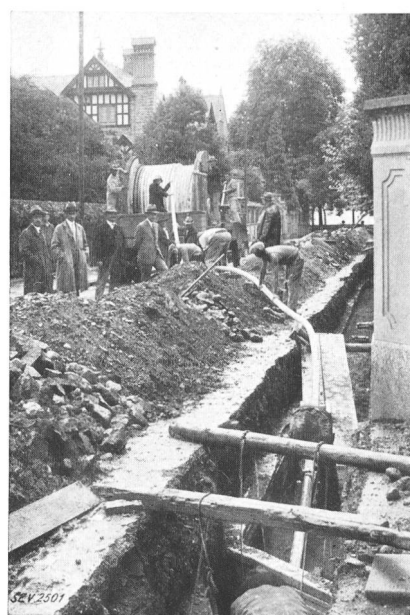
Fig. 8. Verlegen des Landkabels vom Wagen aus über Rollen.
