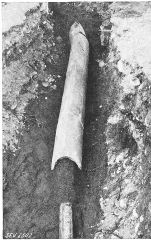
Fig. 9. Einbetten des Landkabels im Kabelgraben. (Sand- und Zementsteine.)
