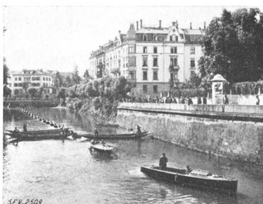
Fig. 16. Spitze des Kabelzuges im Schanzengraben.
