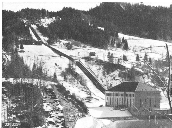
Fig. 5. Druckleitung und Maschinenhaus Rempen.
