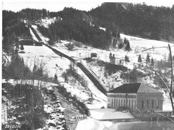
Fig. 5. Druckleitung und Maschinenhaus Rempen.
