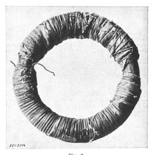
L'anneau avec deux enroulements séparés qui devoit à Faraday pour découvrir l'induction électromagnetique (voir Bull. ASE 1930, No. 19, p. 641/42).
