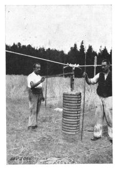
$^{\scriptsize f V}$  Fig. 4. Mitte der Spannweite  $S{-}T$ ; das belastete Seil mit den Belastungsgewichten und der Auslösevorrichtung.
