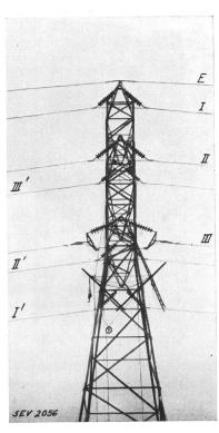
Fig. 6. Probeausführung der neuen Halbabspannung bei Stromleiter III, Mast S, eingebaut. Links nach Mast R, rechts nach Mast T.
