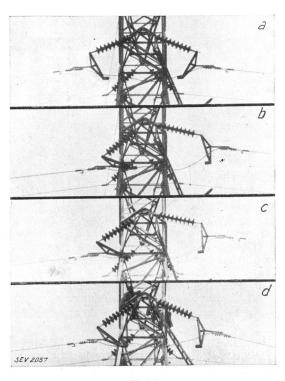
Fig. 7. Neue Halbabspannung an Stromleiter III, Mast S, Mast T hat ebenfalls Halbabspannungen, Mast R hingegen Hängeisolatorketten. Stellung der Halbabspannung bei verschiedenen Belastungszuständen.
