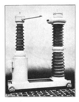
Fig. 10. Freiluftex pansionsschalter 100 kV, 600 A, Abschaltstrom 10 kA.
