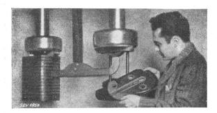
Fig. 29. Deïon-Hochspannungs-Oelschalter. Kontakte für 110 kV.
