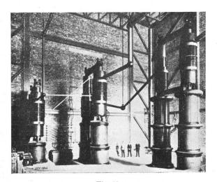
Fig. 22. Prüftransformatorenanlage für 500 kVA, 1 100 000 V. (Häfely, Basel.)
