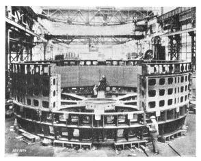
Fig. 6. Aufbau des Statorkörpers der Generatoren für Ryburg-Schwörstadt. (BBC)
