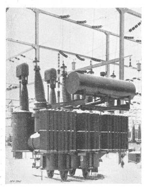
Fig. 20. Zusatztransformator mit Anzapfschalter für das Kraftwerk Ryburg-Schwörstadt. Durchgehende Leistung 32500 kVA, Spannung 145000 ± (8–2900) V. (BBC).
