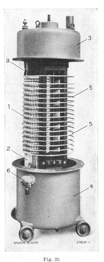
Isoliermantel-Spannungswandler für hohe Spannungen. Isoliermantel abgehoben. (BBC).
