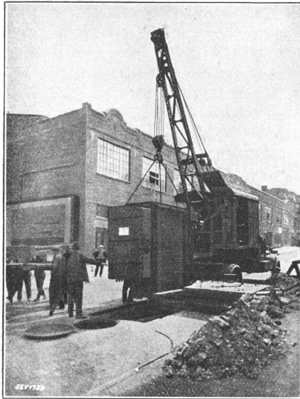
Fig. 12. Einsenken eines Transformators in die Grube.
